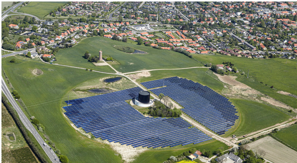
Rysunek 13. Farma solarna (20 tys. m 2 ) współpracująca z akumulatorem ciepła
